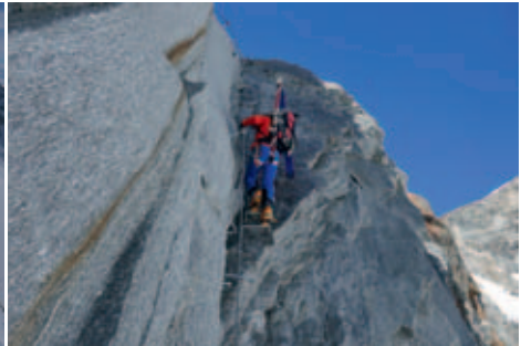
Sanierter Abstieg auf der Ostseite
